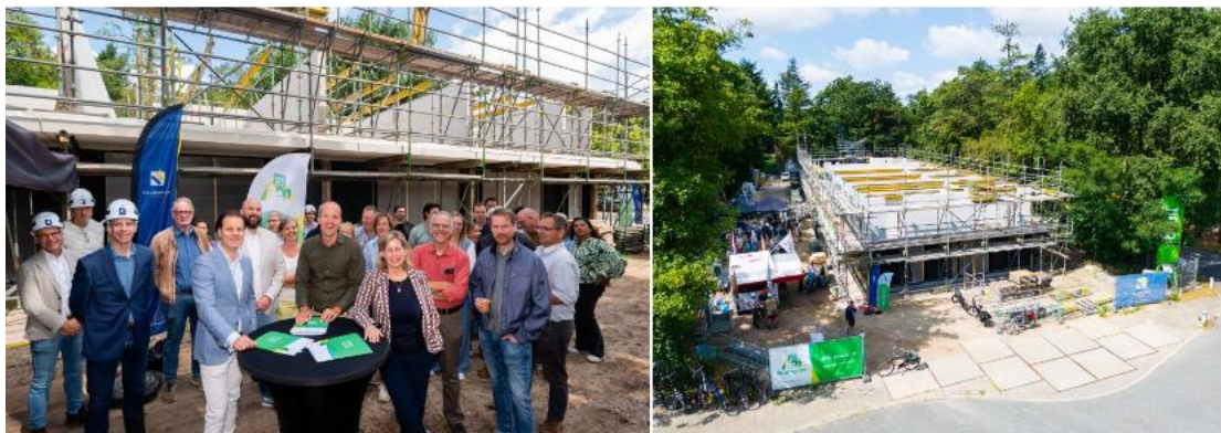
Impressie officiële start nieuwbouw Vondellaan.
