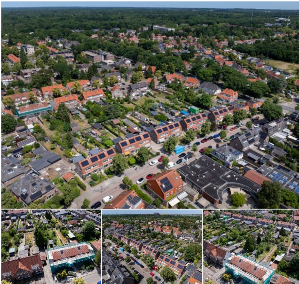
Impressie groot onderhoud en verduurzaming 28 woningen Patijnkwartier
